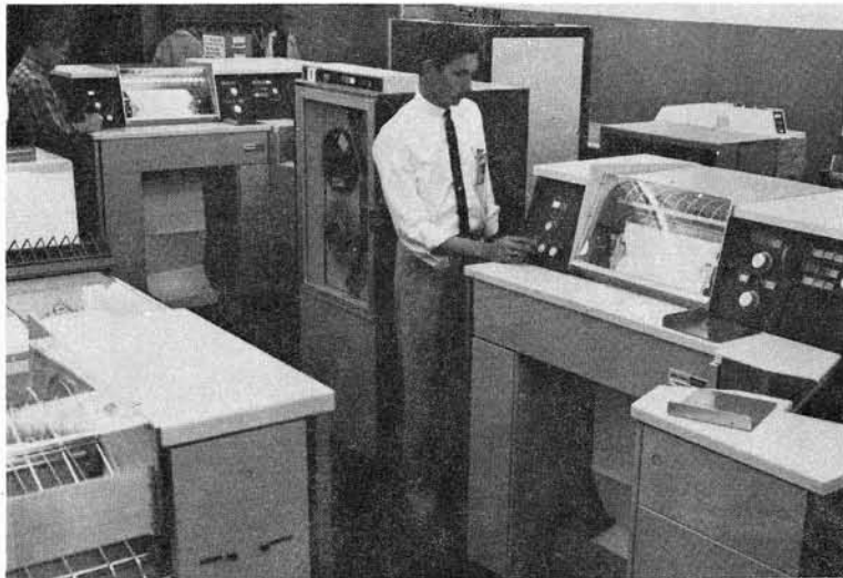
MSFC DATA CENTER 1004 PROCESSORS
