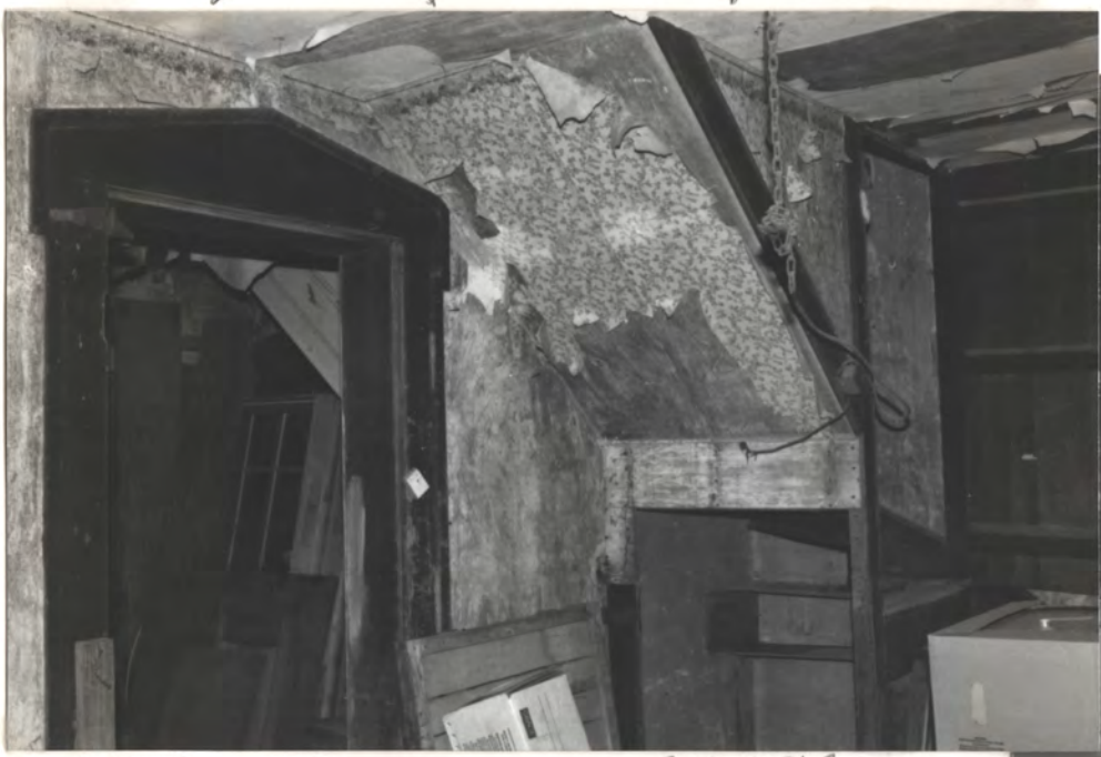
S. DOOR TO HALL
