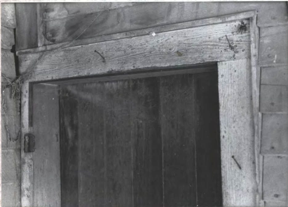
DOOR HD. AT S. PORCH TO ORIG. LOG RM.
