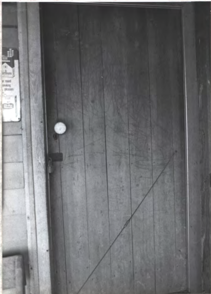
N. PORCH DOOR TO ORIG. LOG RM. (BD. & BATTEN DOOR MAY BE C. 1842)
