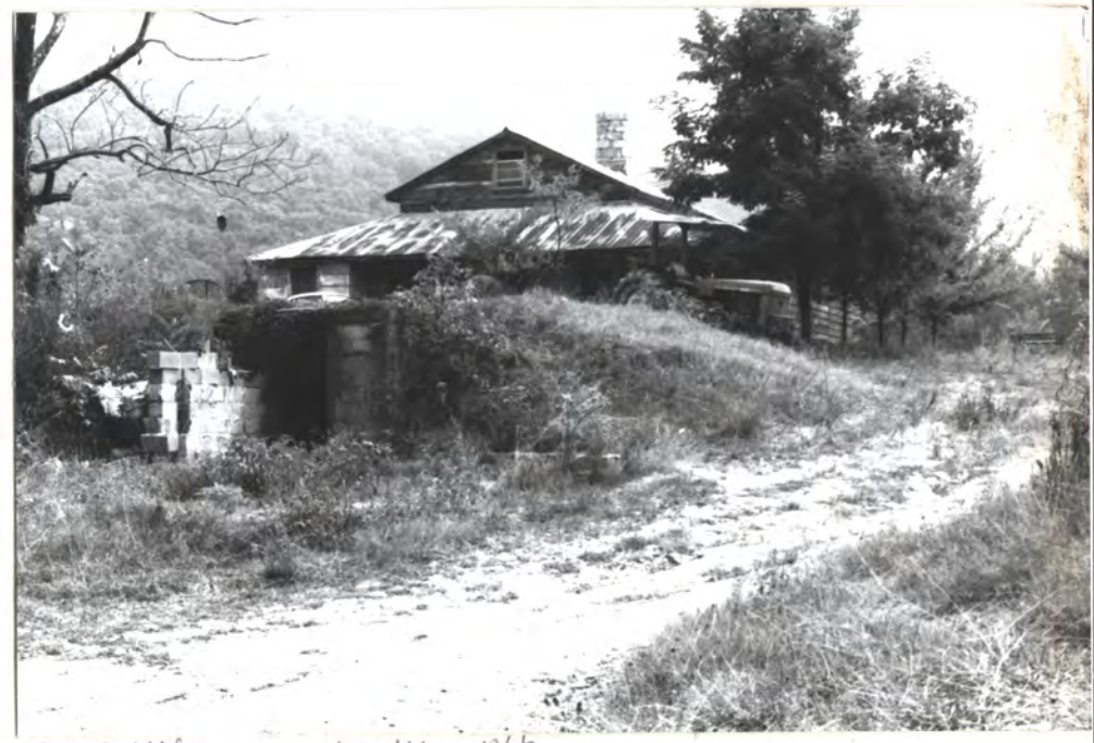
N. WALL - EAST
