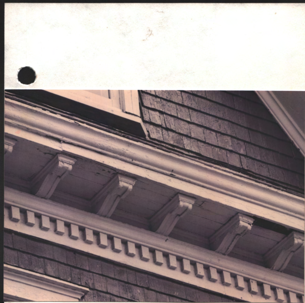
S.E. GABLE, BOTTOM CORNICE
