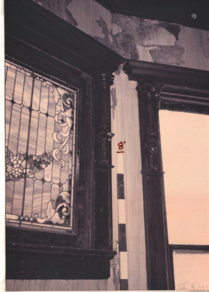
N. WALL, N.E. WINDOW HD.
