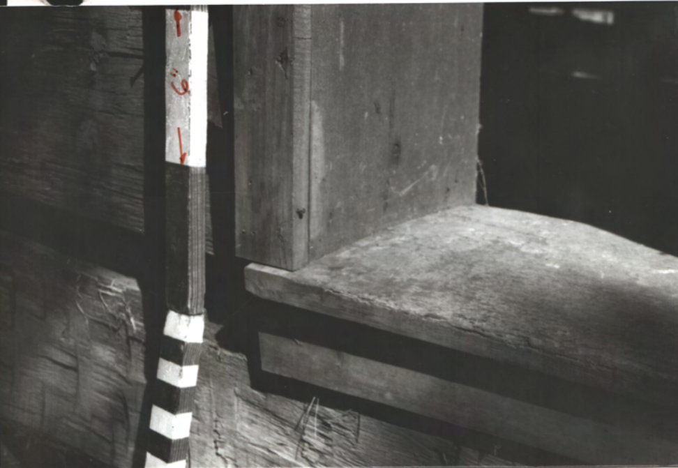
Door sill at orig. central door
