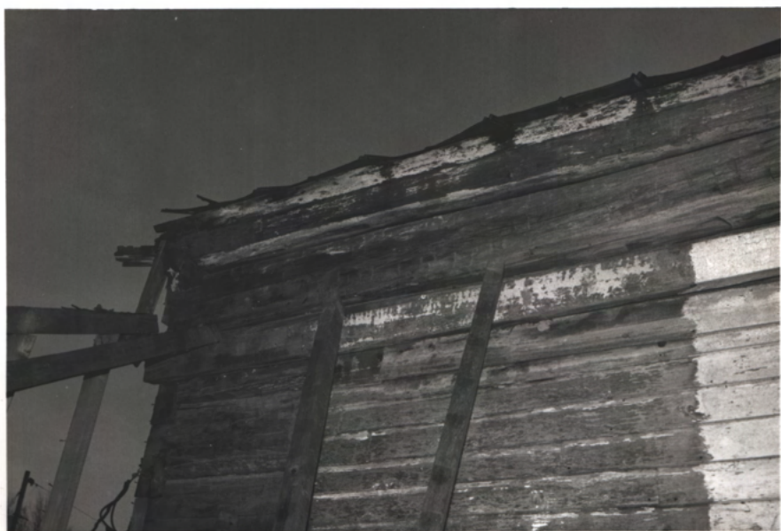
45° fascia at N. wall, E. corner
