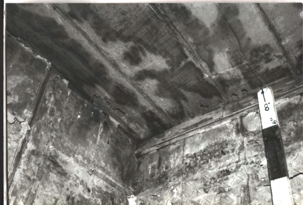
NE Corner E. WALL
