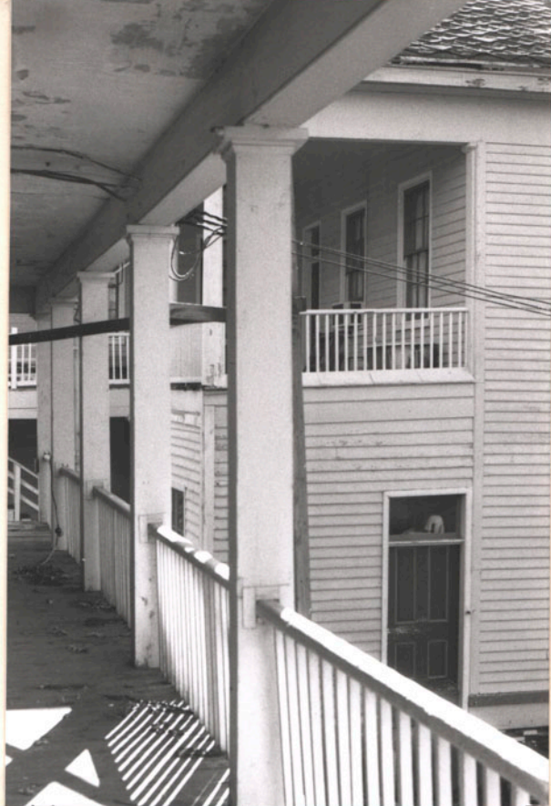
Serv. Bldg. Upper Porch
