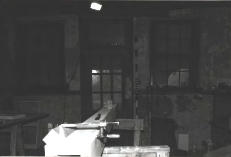
N ← N.E. Basement (under N.E. Parlor)
