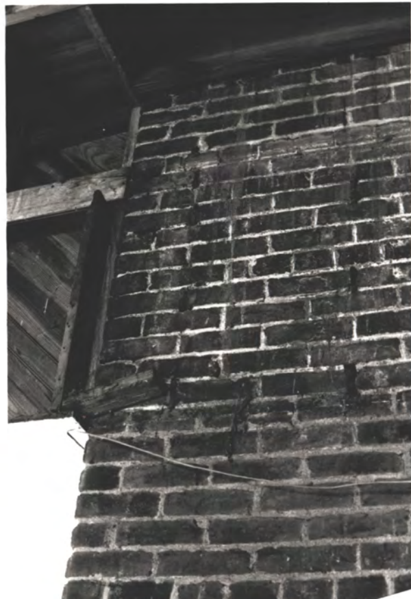
S. WALL OF N.E. PORCH
