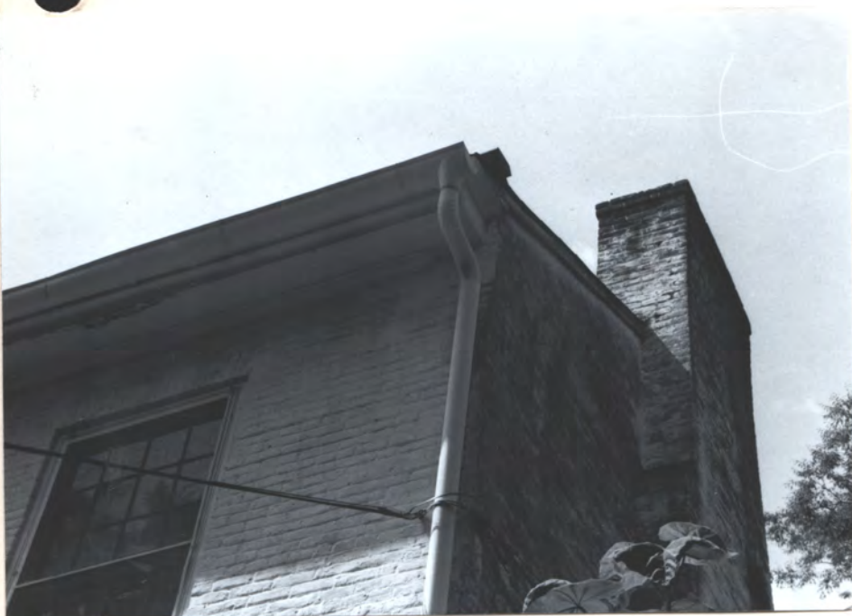
S. WALL E. WALL N. E. WING
