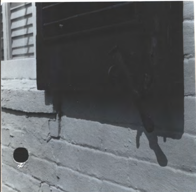
W. WALL, S. WINDOW, SHUTTER-DOLG
