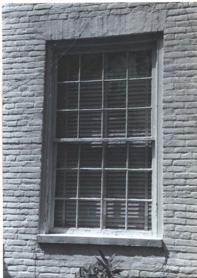
S. WALL OF N.E. WING
