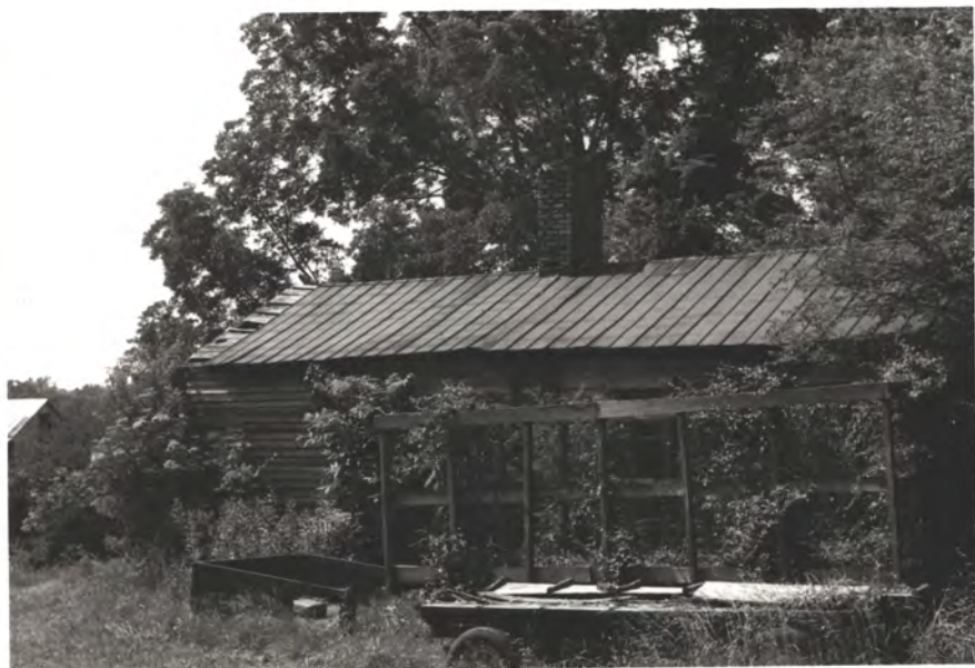
SEEN. BLDG. S. WALL
