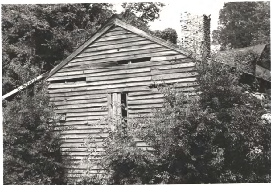
SEEN. BLDG. W. WALL
