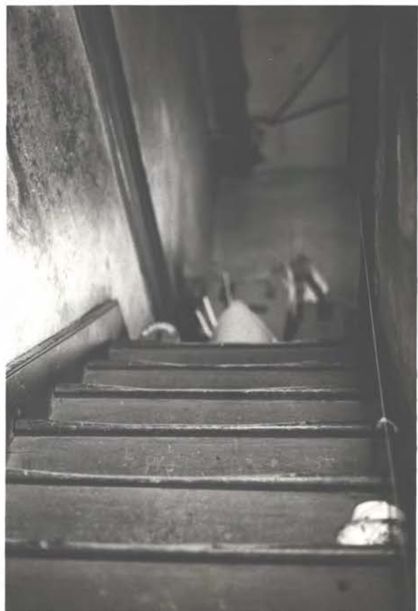
BACK STAIR (IN N. E. WING)
