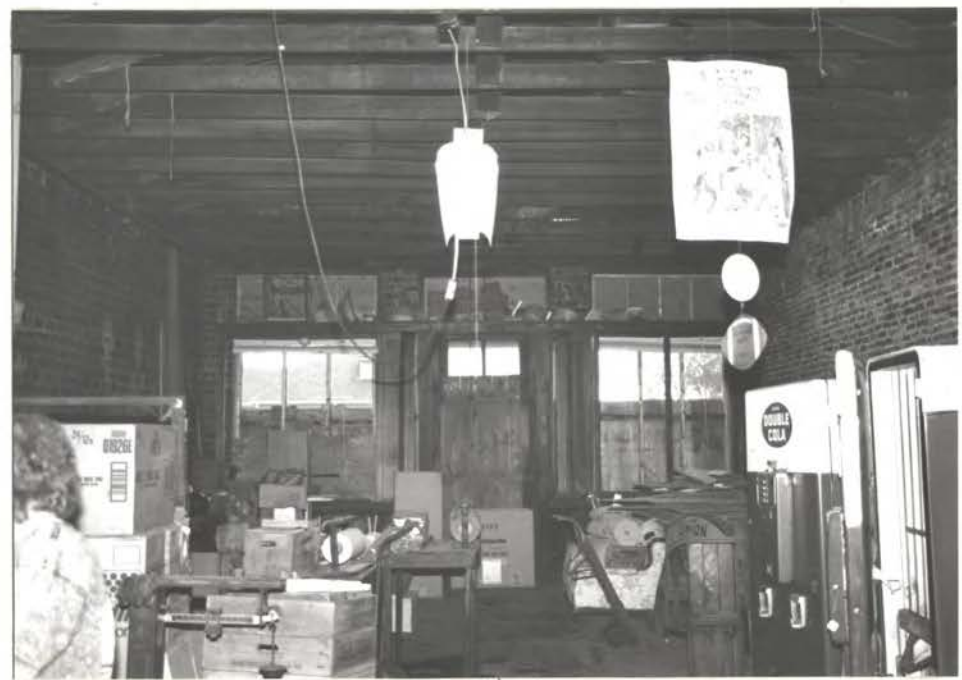
Metals-clad wood fire door separating the N. & Center Bldg. (N. bldg = store, Center bldg = stock- rm.)
