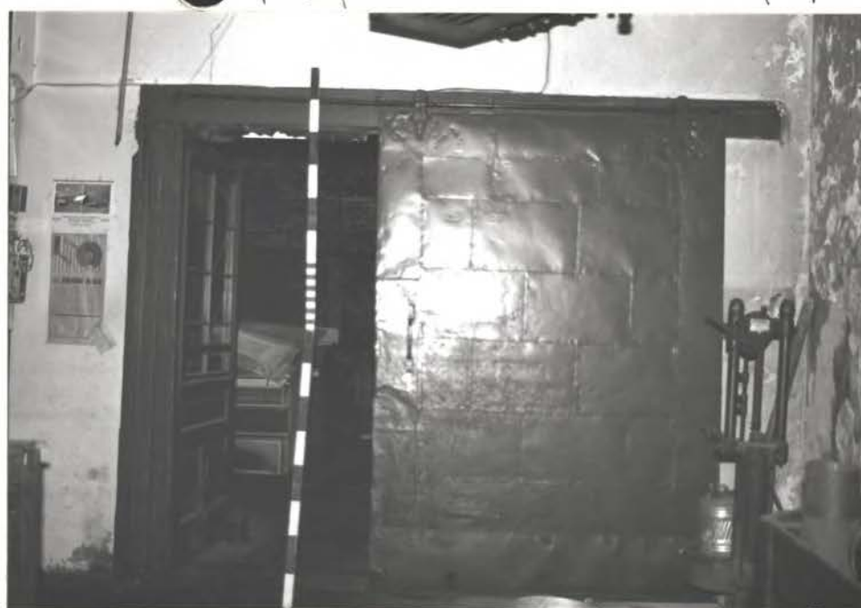
Metals-clad wood fire door separating the N. & Center Bldg. (N. bldg = store, Center bldg = stock- rm.)
