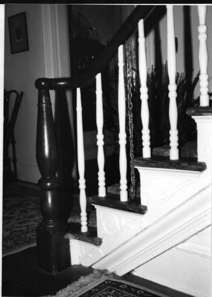
Orig. Stair N.E.
