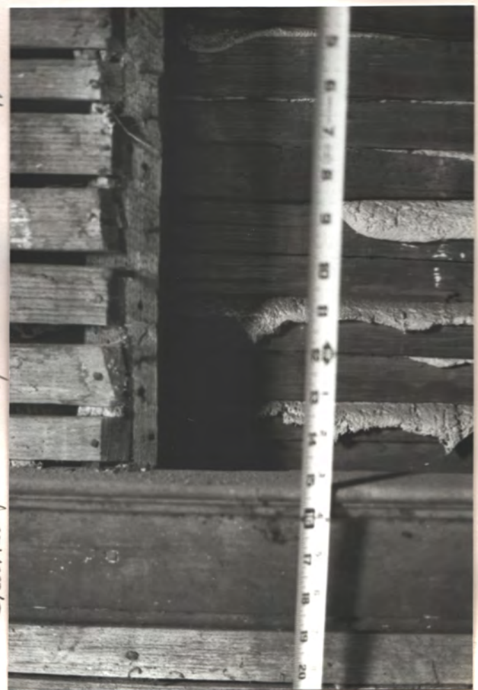
4N "window" at N. W. of S. RM 30
