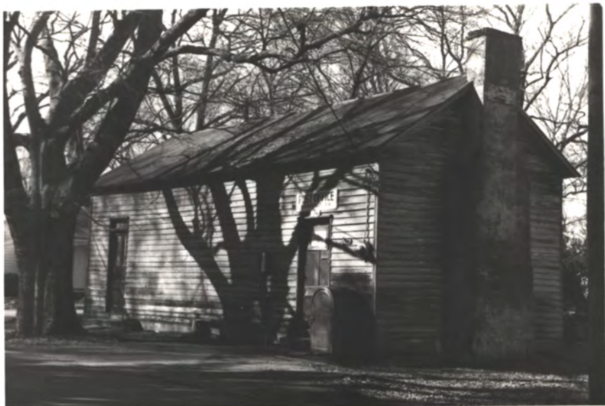
S. & E. walls
