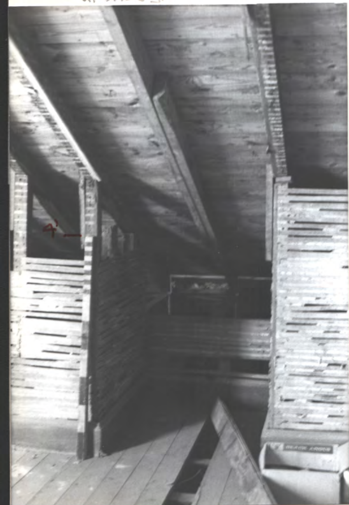
Removed N. dormer
