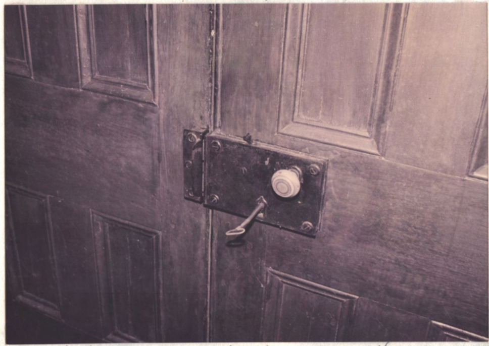
N. Front entry (inside) → N
