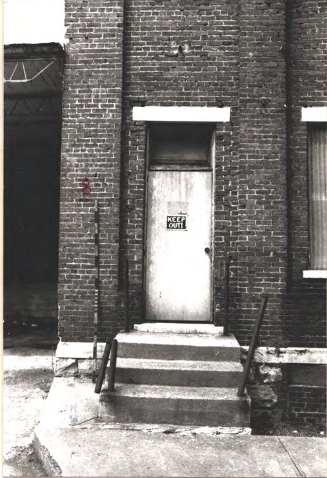
S.W. ENTRY - 1889 BLDG
