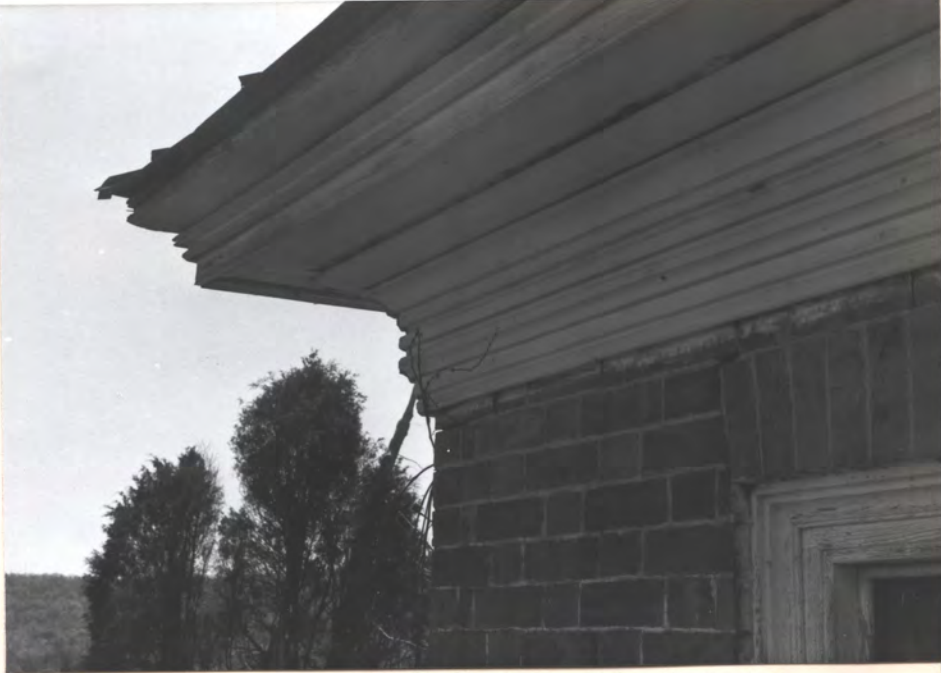
2ND FL. E. WALL, S. E. COR.
