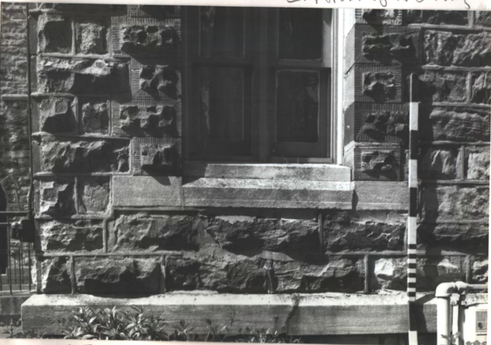
S.E. corner of N.E. Wing
