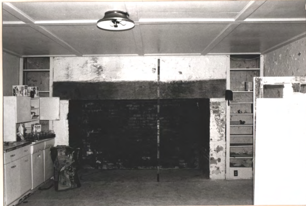
E. WALL (F.P.) original cooking fireplace 25 1/2 h. x 5' + w.
