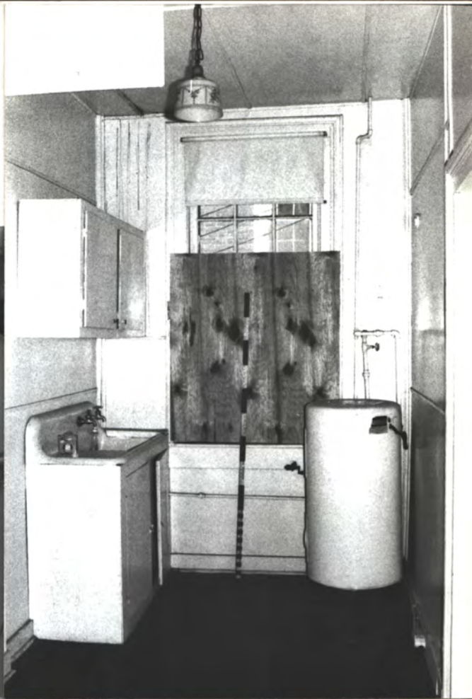
N.W. Rm (N. of stairs) N, WALL
