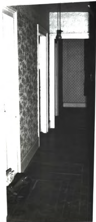
N.E. Rm. door / S.E. Rm. door / S.W. Rm. door
